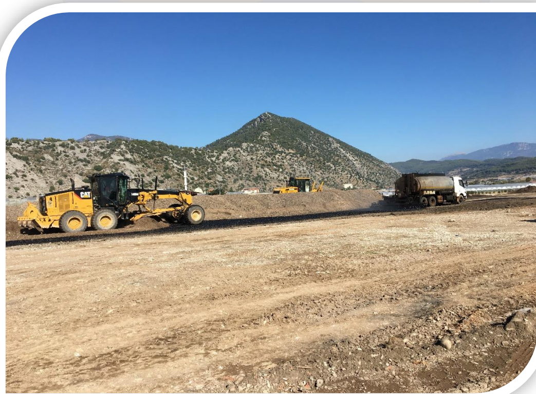
Asfalt Yol Yaması Karılması İşi
